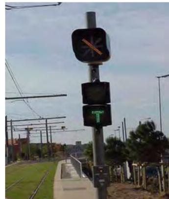
**Figure 3 : Photo avec un indicateur de position d'aiguille (en haut) et un signal rouge/vert**
